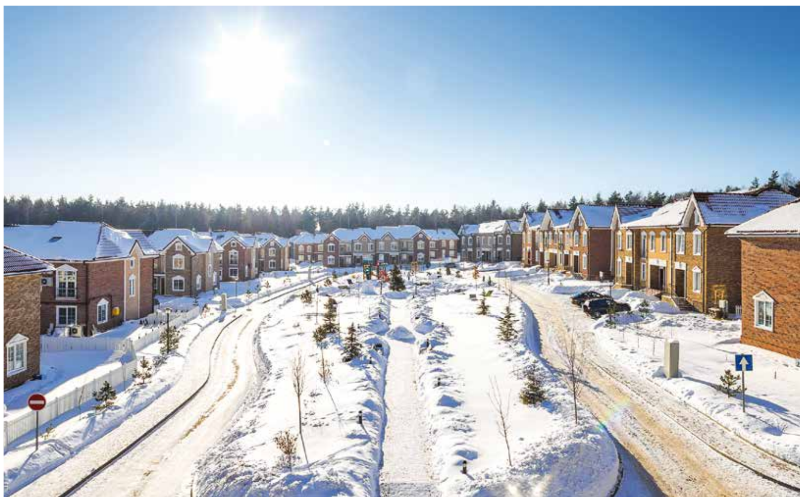
Жилой комплекс «Домодедово Таун»
